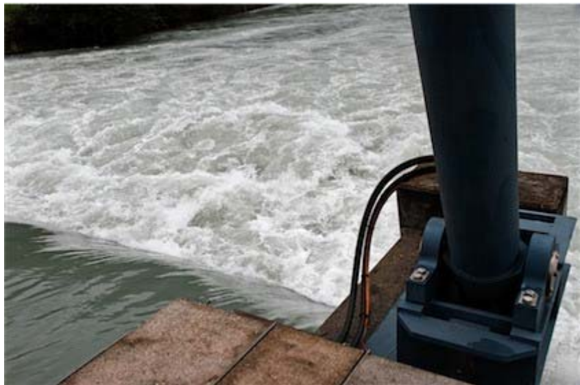
In der Gurbe steht das neueste Wasserkraftwerk der IBI: Das Dotierkraftwerk mit Wehranlage wurde 1997 in Betrieb genommen.
